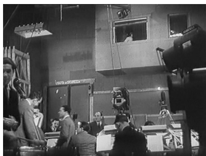
Fig. 27: Veduta della cabina sonora dal set. Sul fondo due macchine da presa affiancate, poste dietro l'orchestra: una con cuffia insonorizzatrice ed una senza. La posizione delle macchine da presa, vista la distanza dal set, potrebbe essere una ricostruzione
